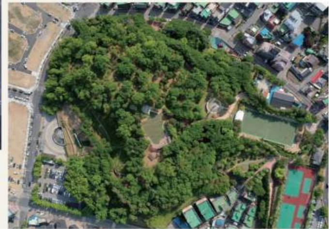
경안근린 명품공원 조성공사
